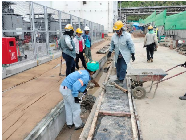
รูปที่ 2-14 การทำความสะอาดรางระบายน้ำและขุดลอกตะกอนดิน
